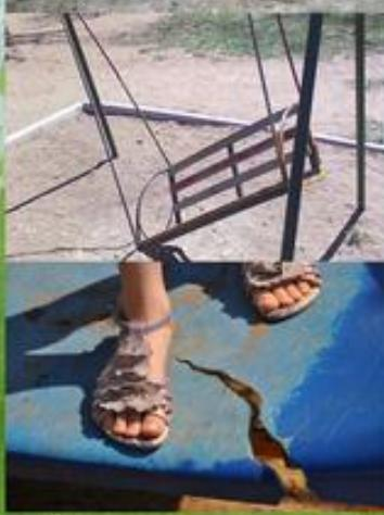
ненадлежащее закрепление элементов сооружений, опрокидывание которых может повлечь травмирование детей (например, незакрепленные теневые навесы, качели, перекладины, брусья)
