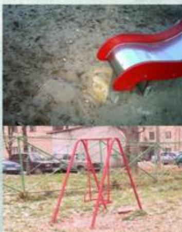
отсутствие демпфирования удара покрытием площадки (например, поверхность под горками, качелями вытоптана до твердого состояния)
